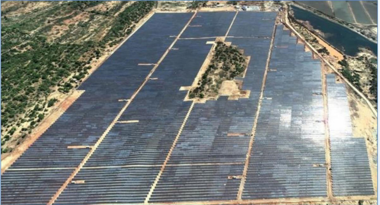
Điện mặt trời Thuận Nam 19 Thuan Nam 19 Solar Power
