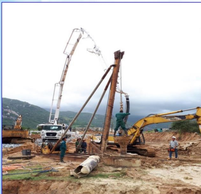
Hệ thống cọc nhồi huyện Thuận Bắc Cast-in-place pile system in Thuan Bac District
